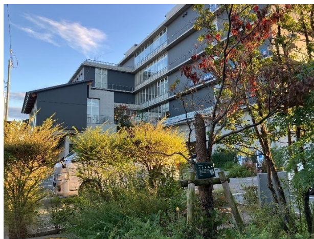
公共施設の緑（市庁舎）
