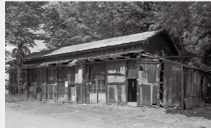
車庫棟解体調査前の現況外観
