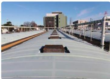
▲反応タンクの中で、微生物の活動を利用して汚れた水を浄化している
