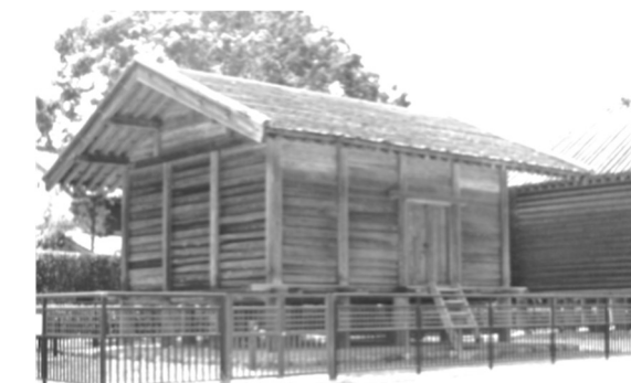
参考 中宿遺跡（深谷市） 史跡公園に復元された榛沢郡衙の正倉
