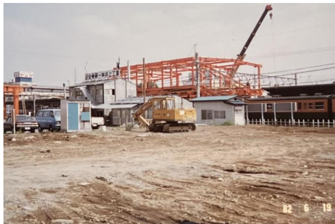
▲ 桶川駅橋上化工事施工風景 (昭和57年(1982)、桶川市歴史民俗資料館蔵)
