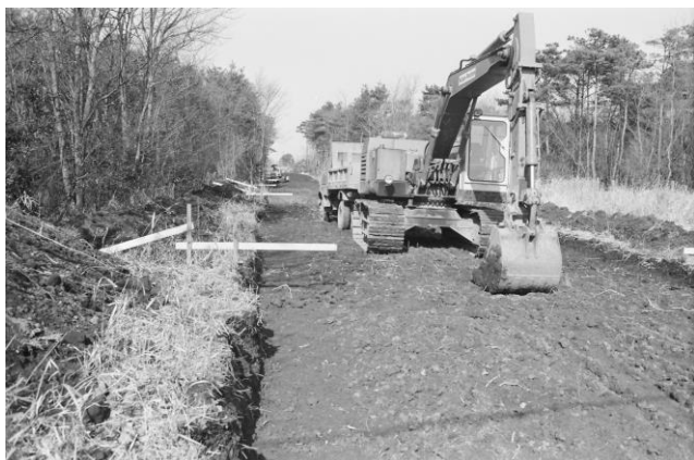
▲ 朝日土地区画整理事業施工風景 (昭和52年(1977)、桶川市蔵)
