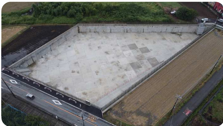
（上日出谷南 2 号調整池）
