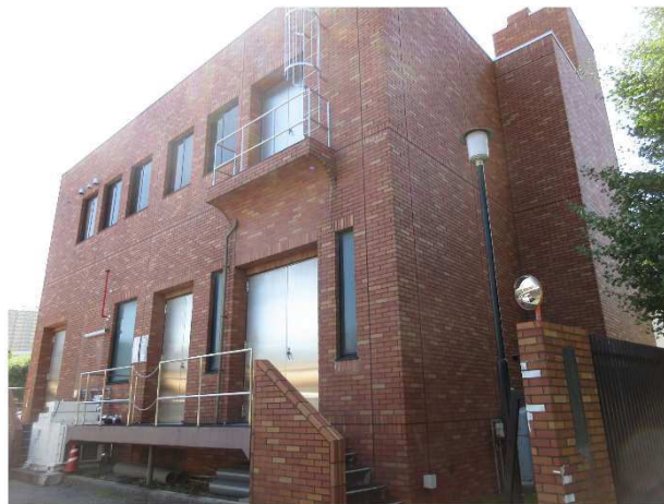
写真 2－4 若宮汚水中継ポンプ場
