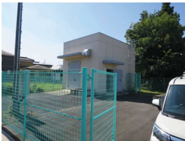
写真２－６ 日出谷污水中継ポンプ場（発電機棟）
