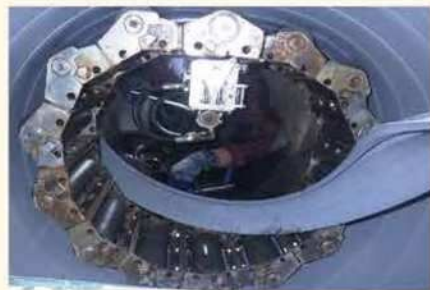
管渠の補修工事
