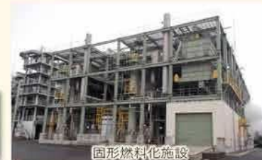
固形燃料化施設
