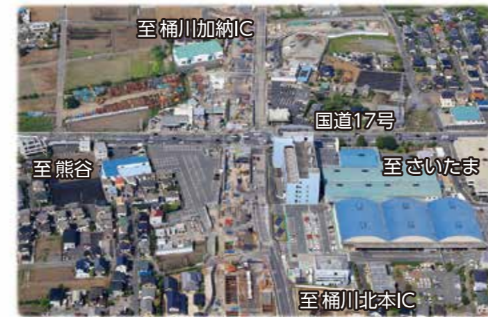
国道17号交差付近から久喜方面を望む (平成26年5月撮影)
