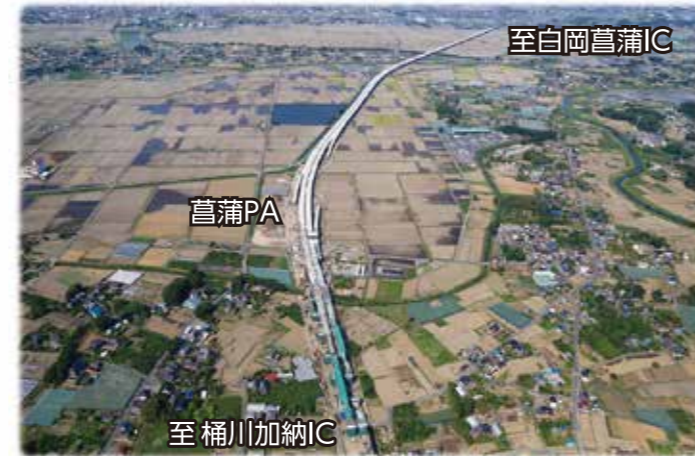
菖蒲PA付近から幸手方面を望む (平成26年5月撮影)
