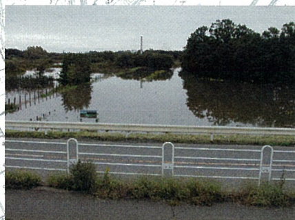
桶川市道17号線(最下流部)
