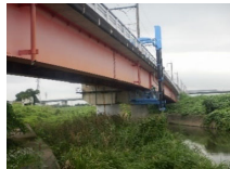
赤堀川道路橋
