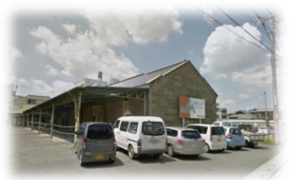
解体される倉庫
