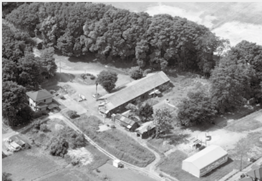
飛行学校施設群航空写真(北東面より撮影)
