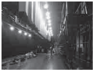
舞台設備工事の様子
