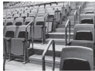
手摺り設置後のホール客席通路
