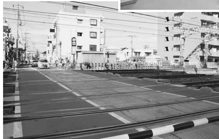
▼改修後の長久保踏切
