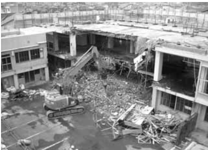
解体作業の状況
