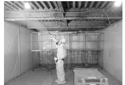
吹き付けアスベスト撤去作業の状況
