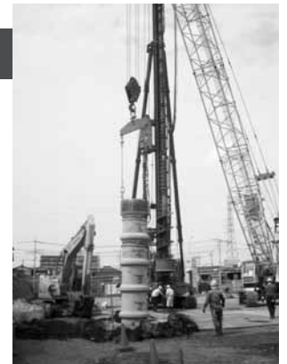
杭工事の状況
