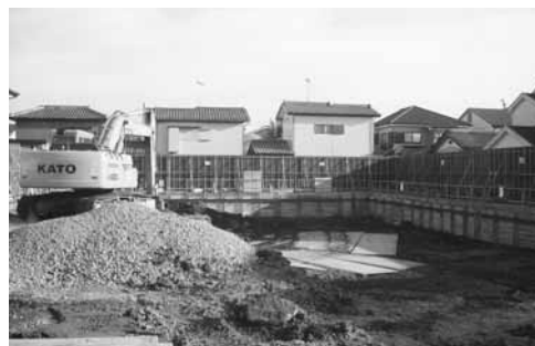
土工事の状況
