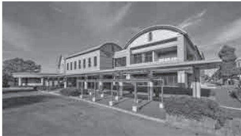
▲川田谷生涯学習センターの 大規模改修工事が完了
