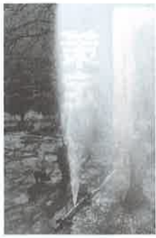
①吹き上がる漏水
