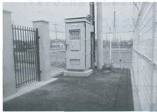
完成した第14号取水井
