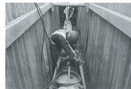
工事施工状況写真
