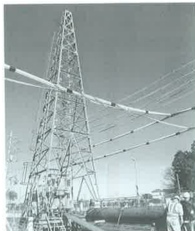
▶工事で使用したやぐらの全景
