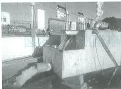
▶井戸水くみ上げ試験の様子
