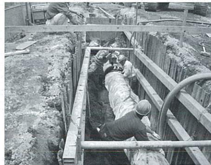
工事施工状況写真
