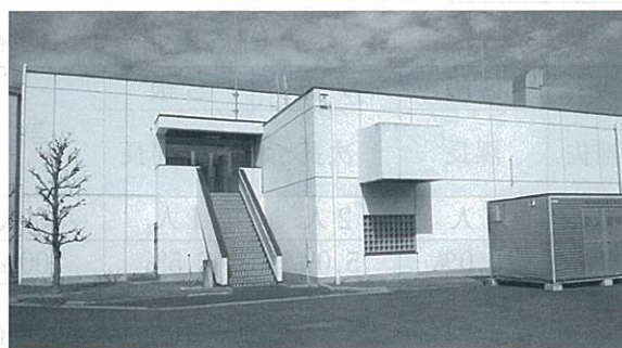
加納配水場管理棟
