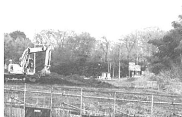
ようやく残土の撤去がされる 上日出谷2号調整池
