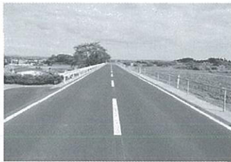
道路復旧状況「震度7東日本大震災 一栗原市の記録より」
