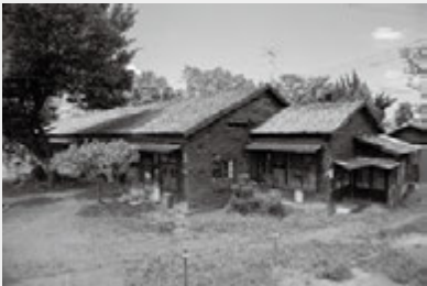
兵舎棟解体調査前の現況外観
