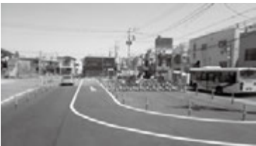
仮設桶川駅東口自動車送迎場
