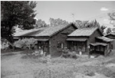
兵舎棟解体調査前の現況外観
