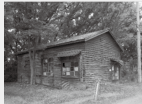
解体前の破損が著しい守衛棟外観写真
