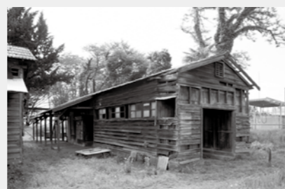
解体前の便所棟外観写真
