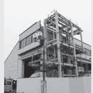
▲エレベーター工事の進捗状況
