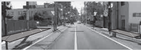
▲仲仙道線の進捗状況
