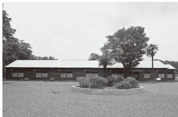
桶川飛行学校平和祈念館 兵舎棟
