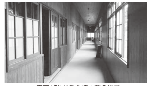
▲工事が進む兵舎棟内部の様子
