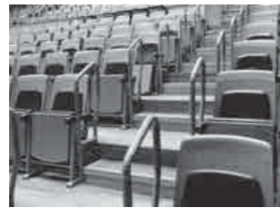
手摺り設置後のホール客席通路
