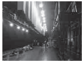
舞台設備工事の様子
