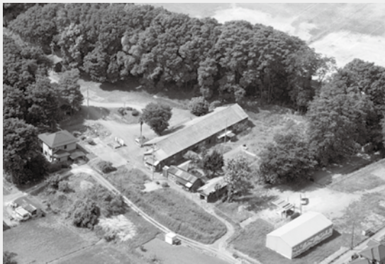
飛行学校施設群航空写真(北東面より撮影)
