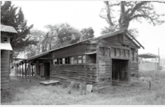
便所棟解体調査前の現状外観
