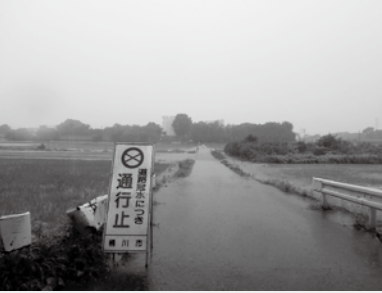
大雨時、毎年のように 道路冠水する江川周辺
