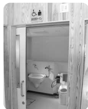
▲多目的トイレ
