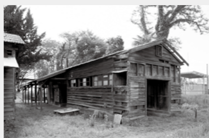
解体前の便所棟外観写真
