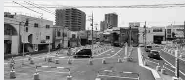
▲事業の進捗状況(駅前広場)
