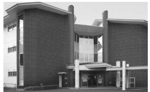
9月改修予定の地域福祉活動センター
