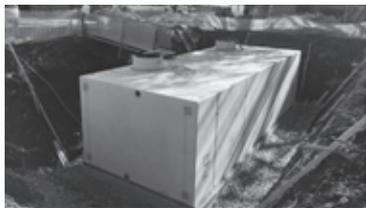
飛行学校整備工事・鋼矢板工法からオープンカット工法に勝手に変えた工事
