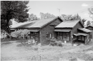
解体前の兵舎棟外観写真
