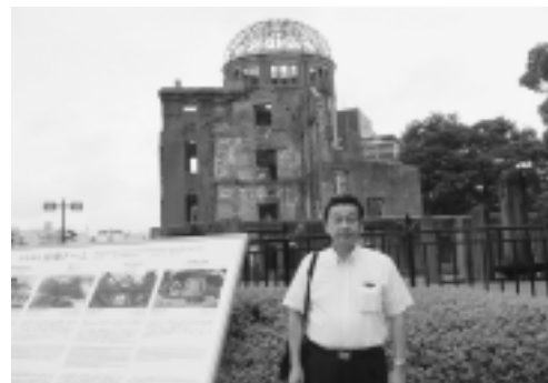
被爆した当時の姿を残す原爆ドーム
