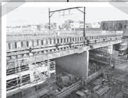
⑤ 高崎線下のトンネル工事
