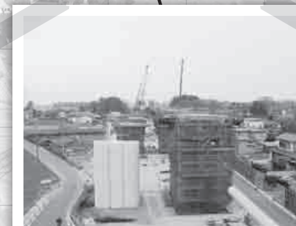
⑧ 橋脚から桶川加納IC方面を望む
