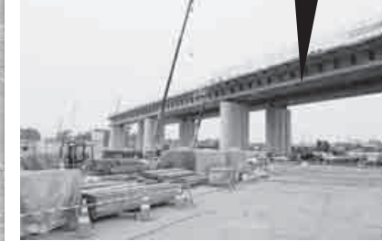
⑨ 桶川第3高架橋
