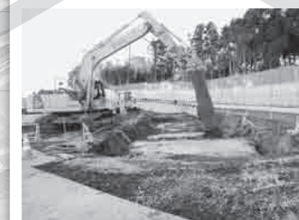
⑥ ランプ土質改良工事
