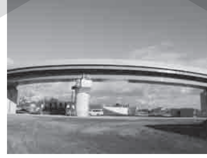
⑦ ランプ橋部分
