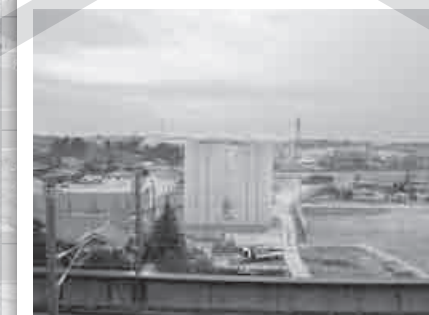
⑩ 橋脚から工業団地方面を望む
