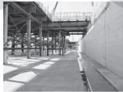
④ 堀割部の工事
