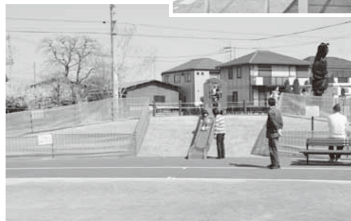
<坂田原南公園整備工事>
