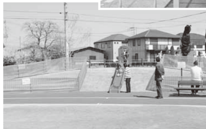
<坂田原南公園整備工事>
