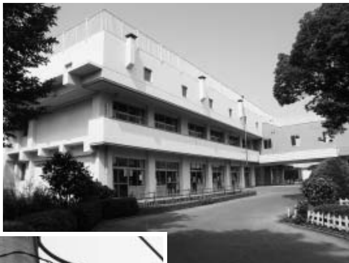
〈朝日小北校舎屋上防水等 改修工事〉
