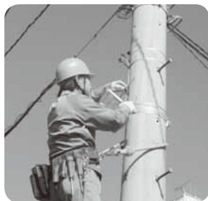
防犯灯LED化工事
