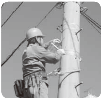
防犯灯LED化工事
