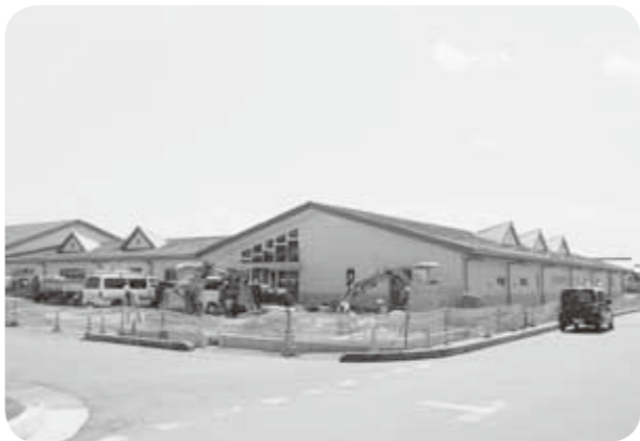
建設中の日出谷保育所・子育て支援センター
