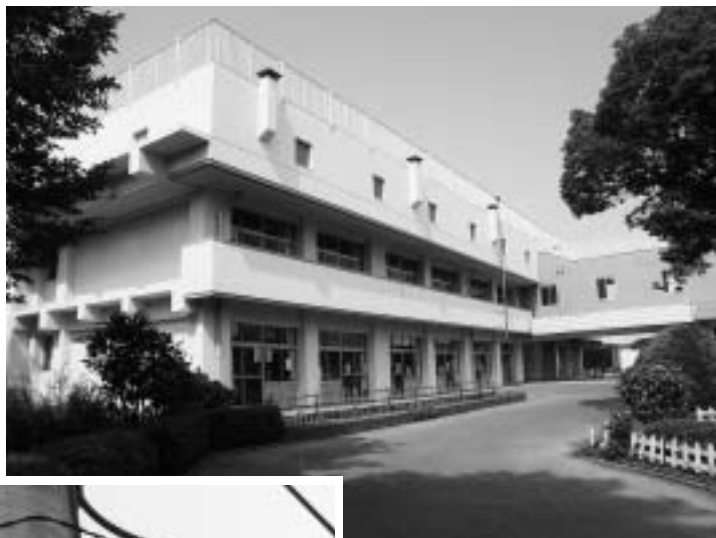
〈朝日小北校舎屋上防水等 改修工事〉
