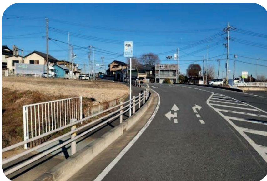
（ガードレールの設置による市道の安全対策）
