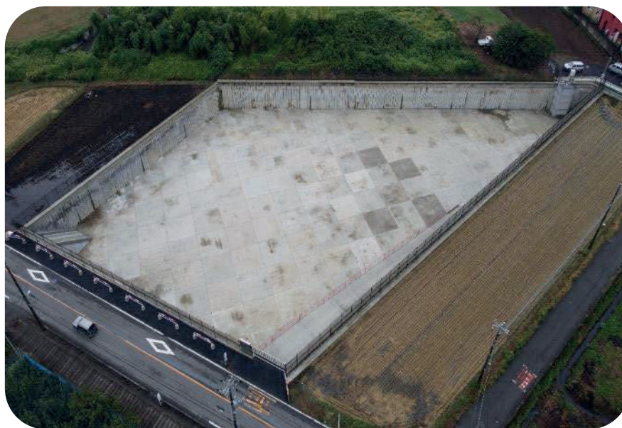
(上日出谷南2号調整池)
